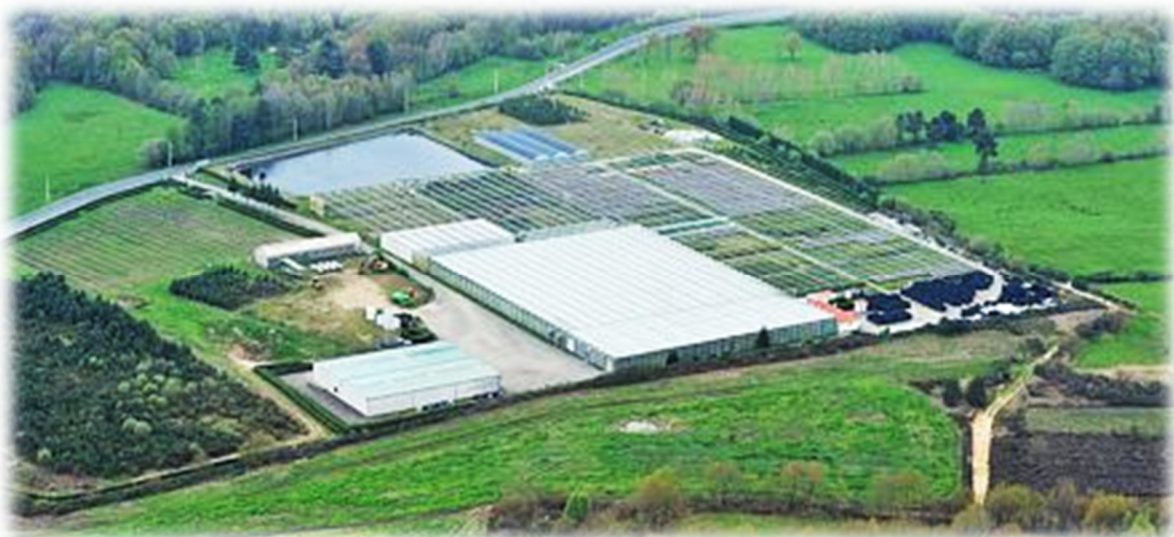
Vista aérea de las instalaciones Vivero de Maceda
