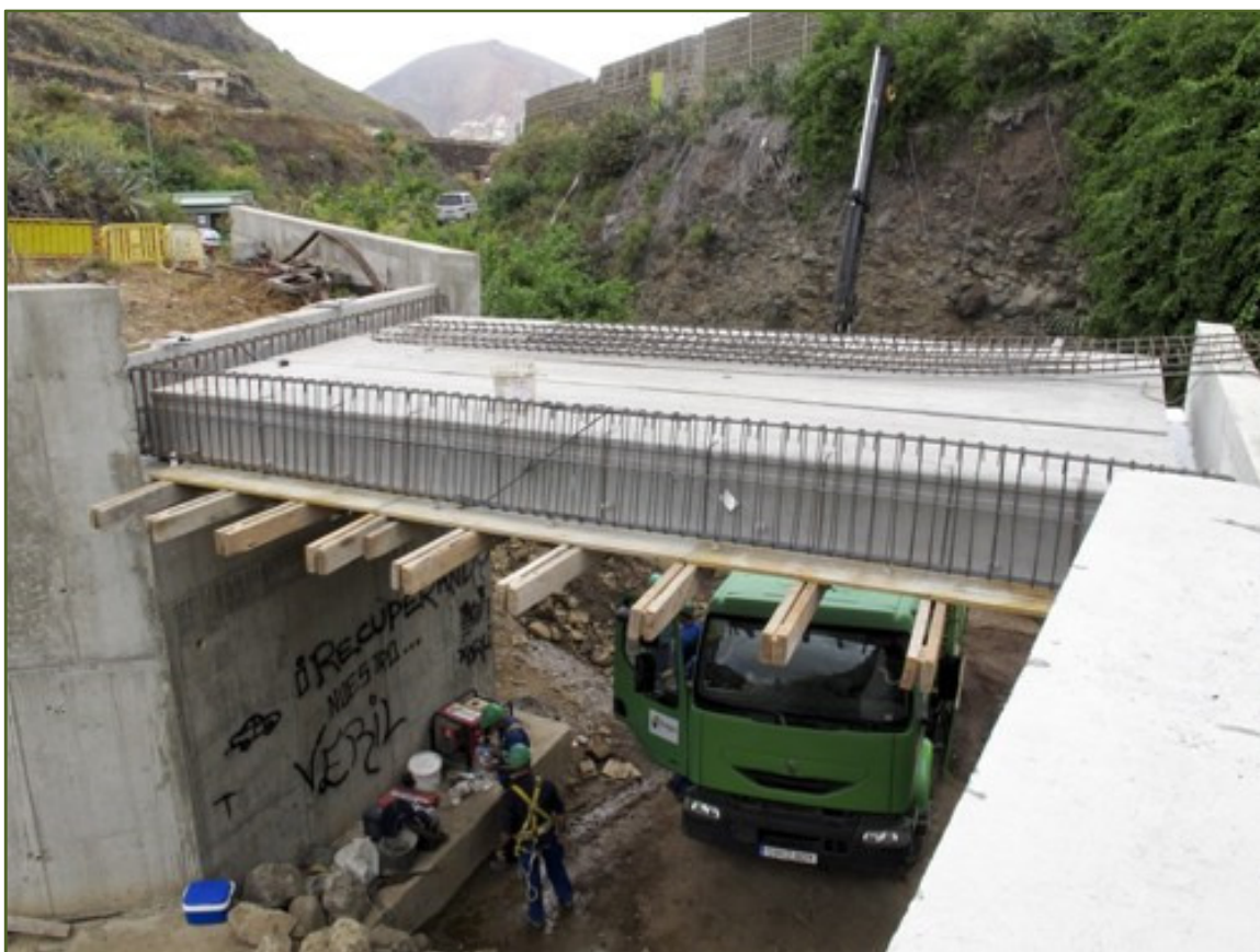
Acondicionamiento e impermeabilización con piezas prefabricadas de la Presa del Conde en Galdar y Santa María de Guía de Gran Canaria.
