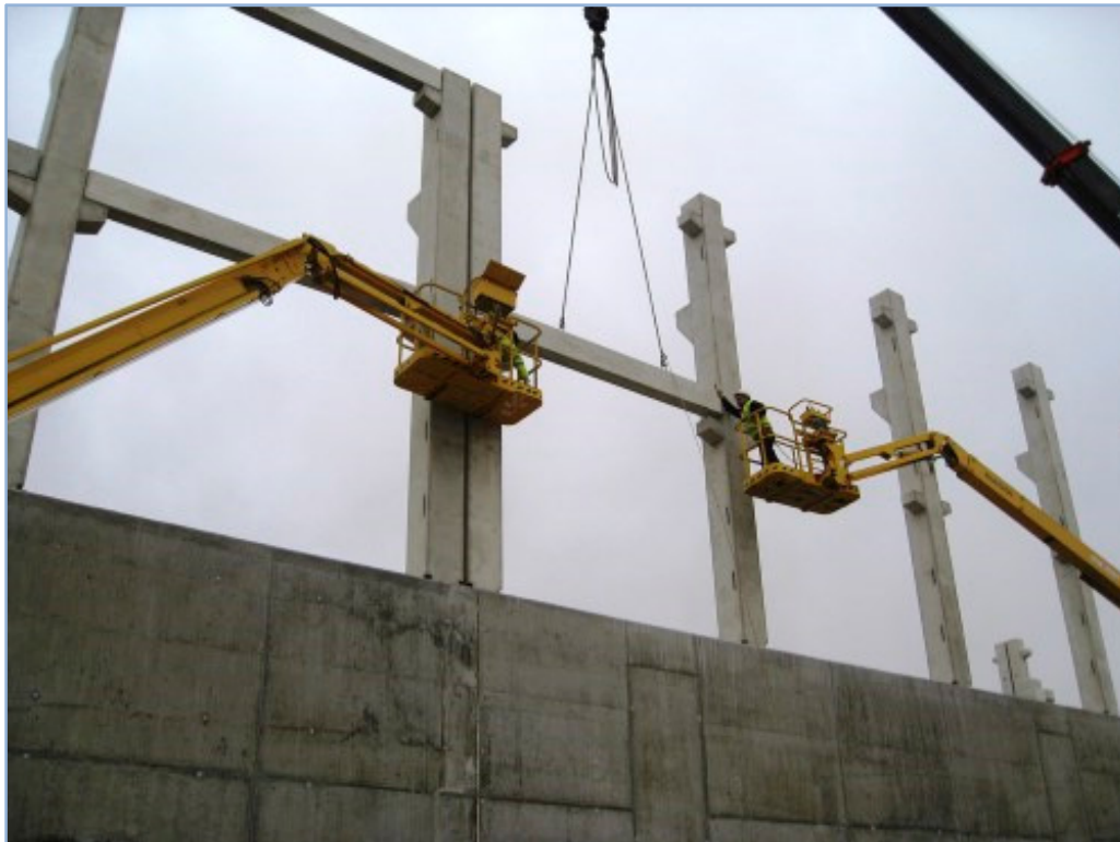
Colocación de Pilares prefabricados hormigón para estaciones de Bombeo en Salamanca, generados en la Planta de prefabricados de Mansilla de las Mulas (León)
