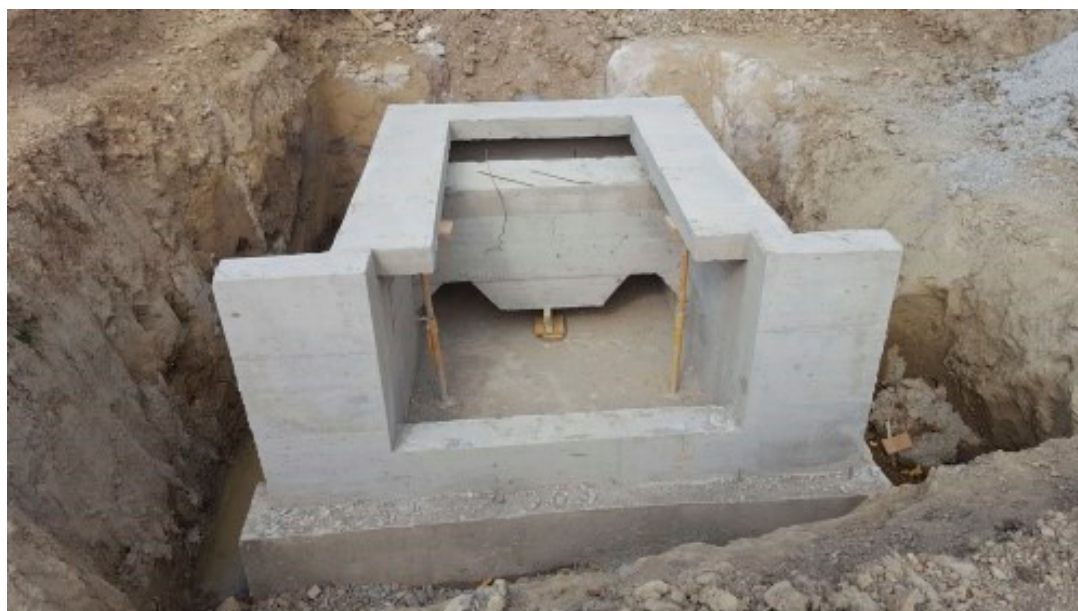
Arqueta de hormigón
