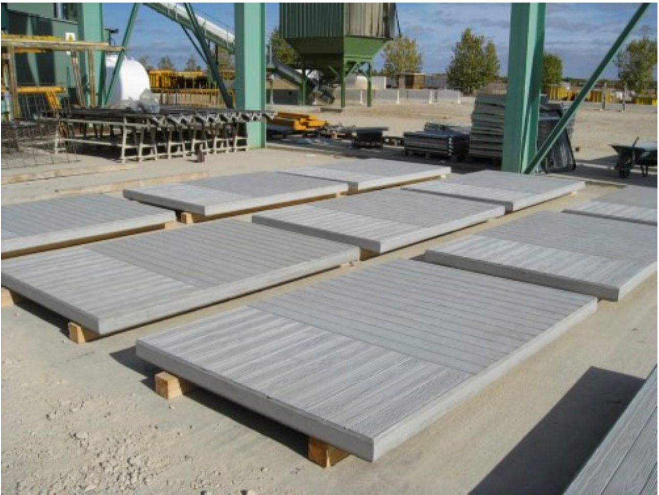
Losas de pavimento prefabricadas
