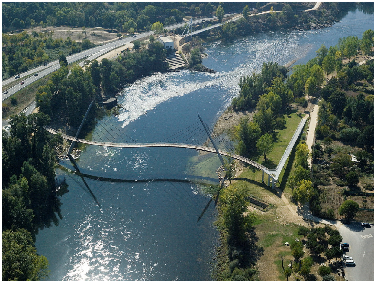
Construcción de una pasarela sobre el río Miño en el Concello de Ourense
