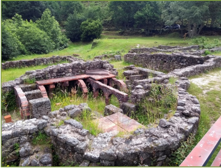
Obras de Infraestructura del Yacimiento de Aquis Originis. Orense
