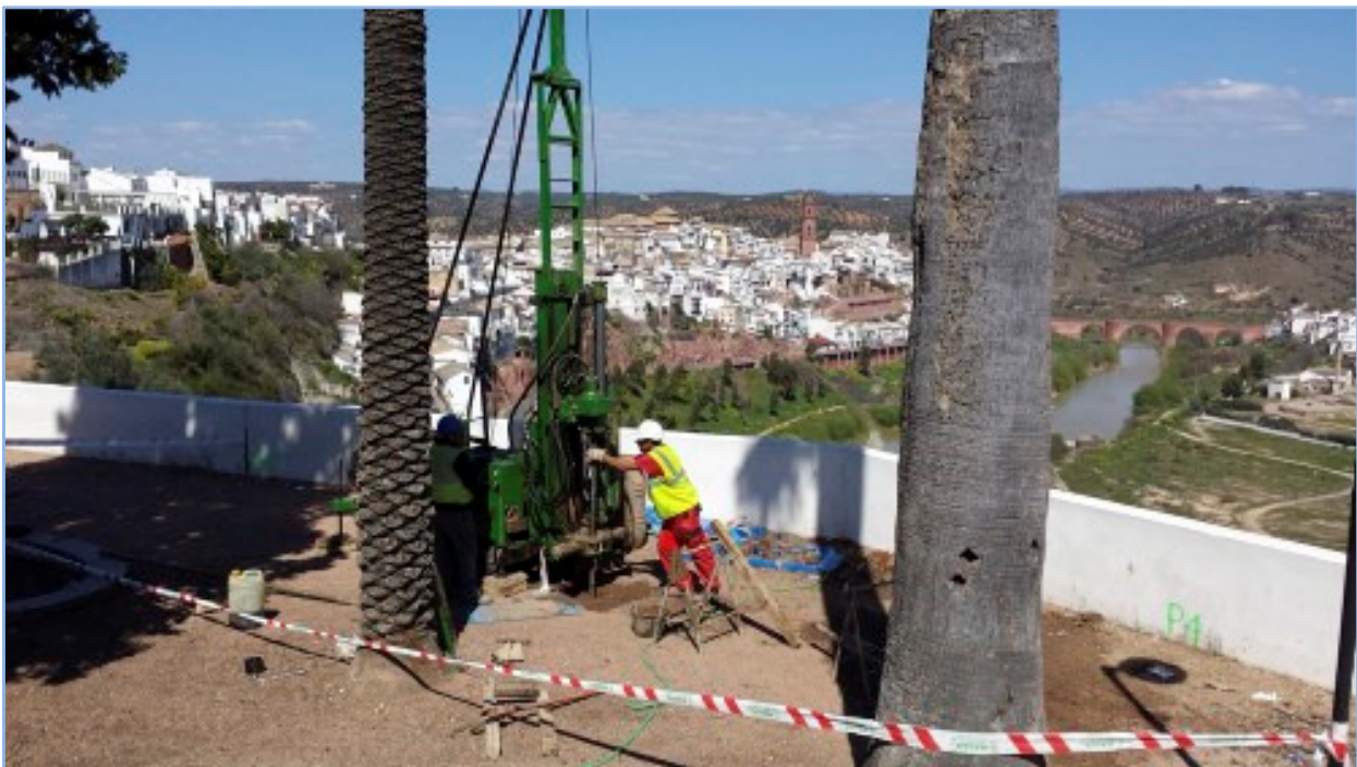
Obras en el muro de contención El Francés en Montoro. Córdoba
