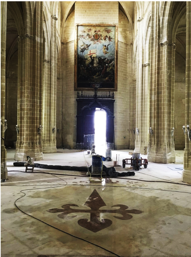
Rehabilitación de la Iglesia de Santiago en Jerez de la Frontera (Cádiz)
