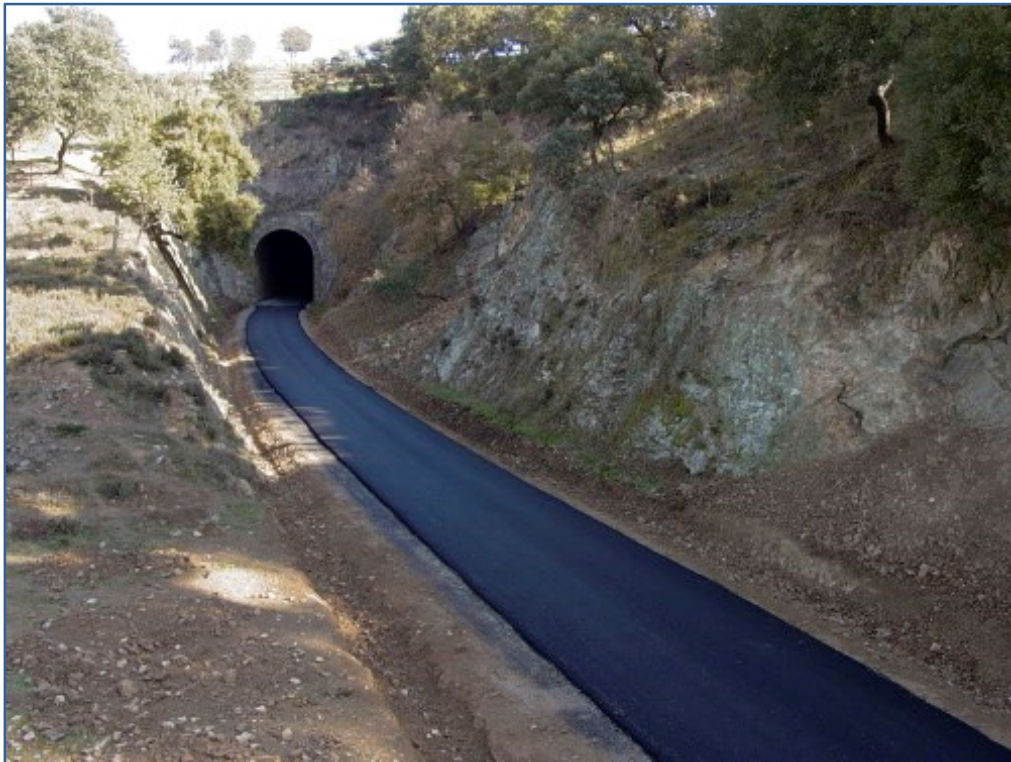
Acondicionamiento de la Vía verde de la Rivera del Hueznar del trazado ferroviario en desuso entre la bifurcación de los Prados y las Minas del Cerro del Hierro. Sevilla
