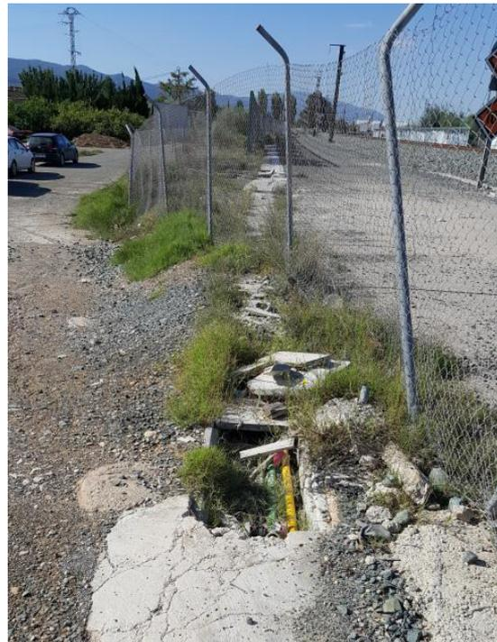
**Canaleta y cableado eléctrico al descubierto**
