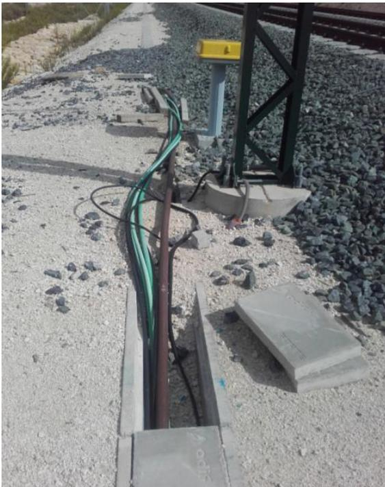
**Cableado eléctrico a recolocar dentro de la canaleta**
