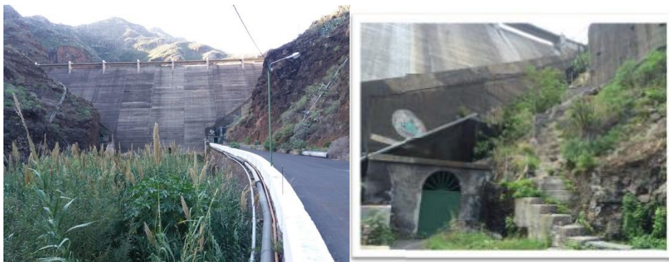
Imagen 1 y 2. Acceso a galerías Presa Chejelipes
