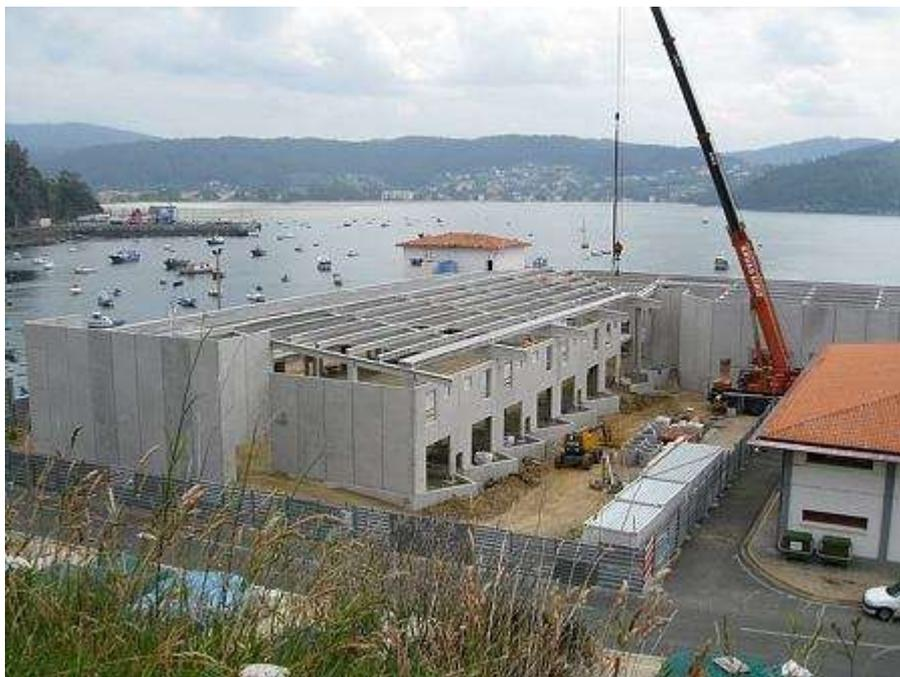
*Construcción del cerramiento de la nueva lonja en el puerto pesquero de Cedeira con prefabricados de hormigón de Mansilla de las Mulas (León)*
