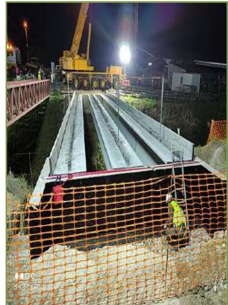
Obras de ejecución de paso superior sobre la línea de ferrocarril Oviedo Santander en Serdio, término municipal de Val de San Vicente (Cantabria).
