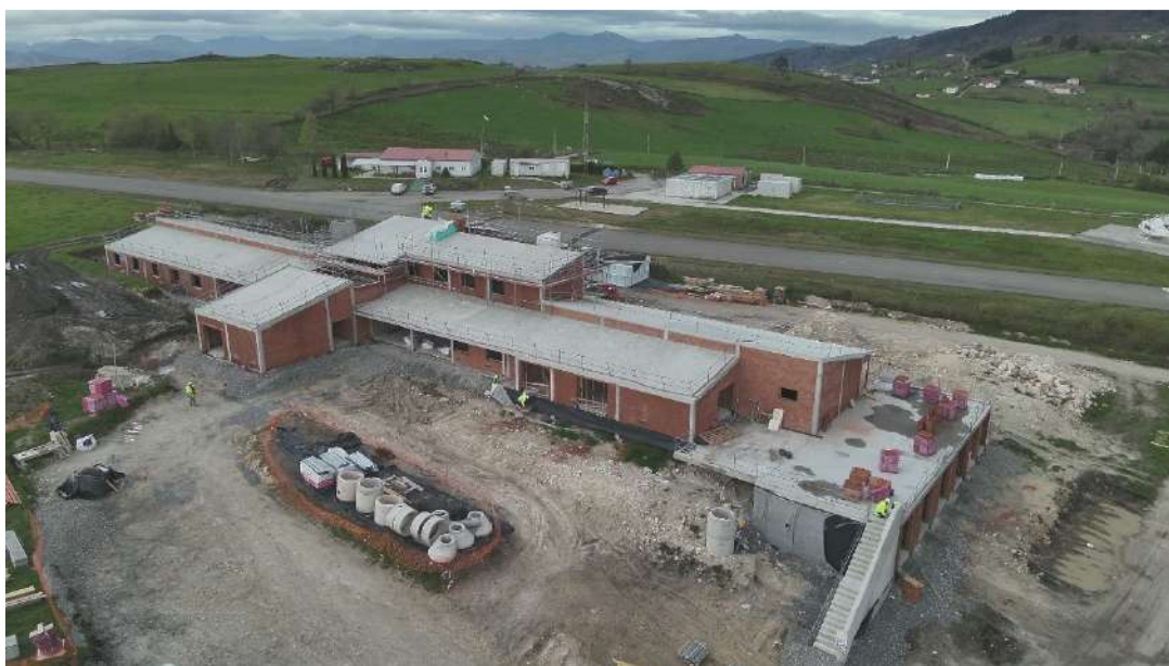
Obras en Base BRIF de Tineo (Asturias).
