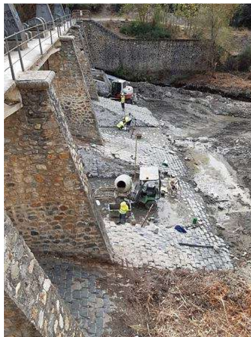
Paso para peces y sedimentos en restauración fluvial del río Genil (Granada)
